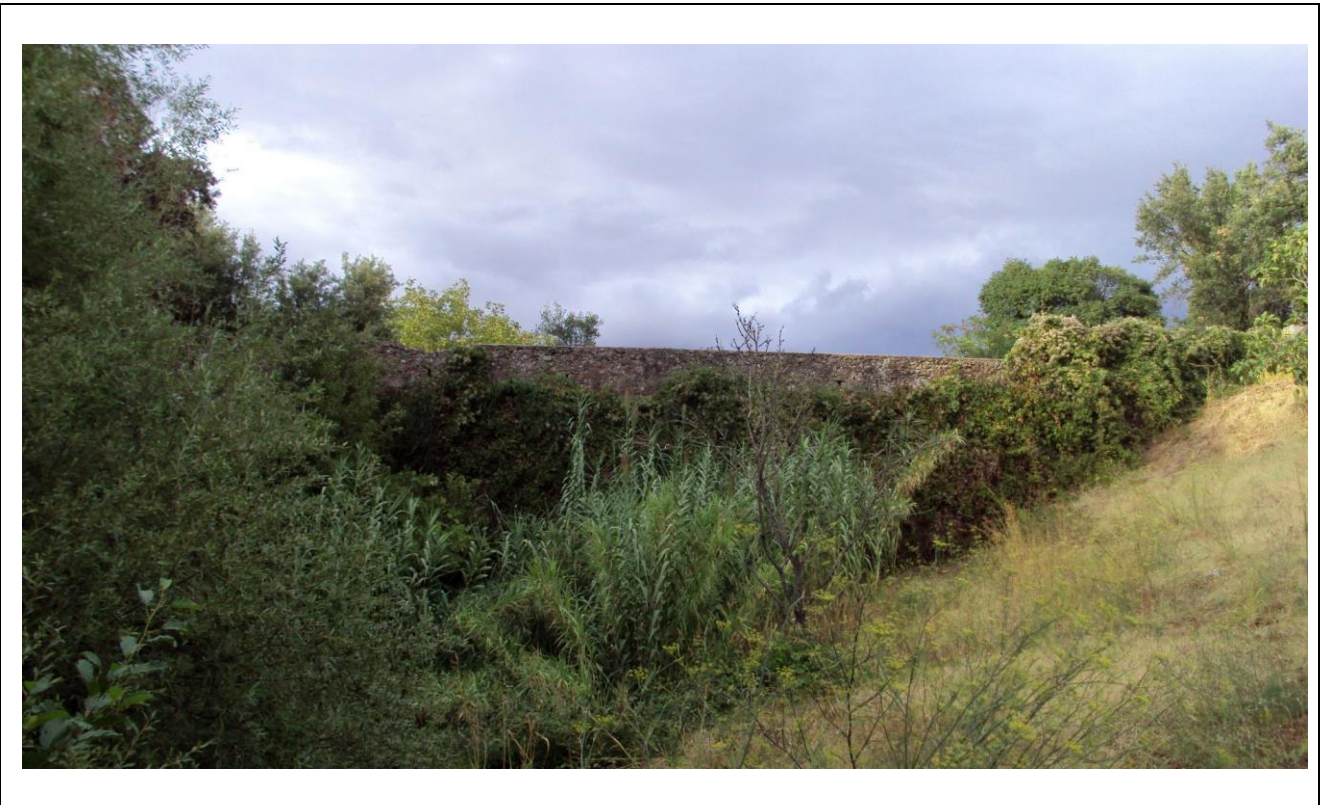
Il vecchio ponte “Reka” (visto da sotto)
