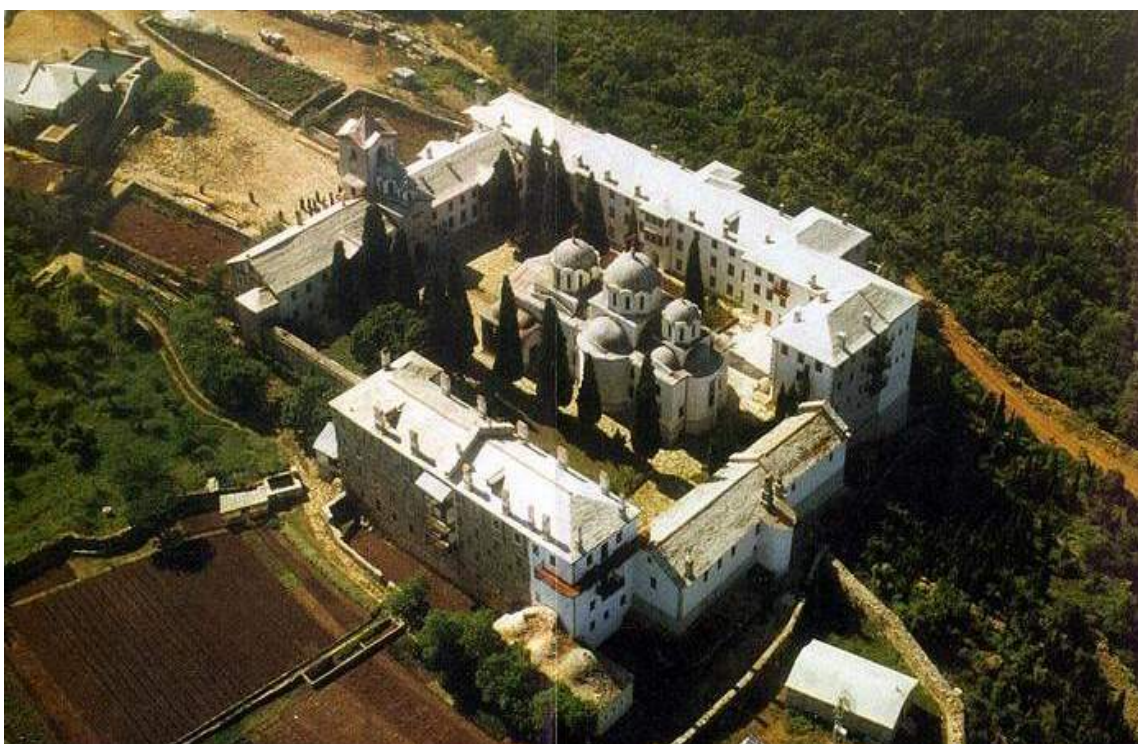
Veduta aerea della Grande Lavra
