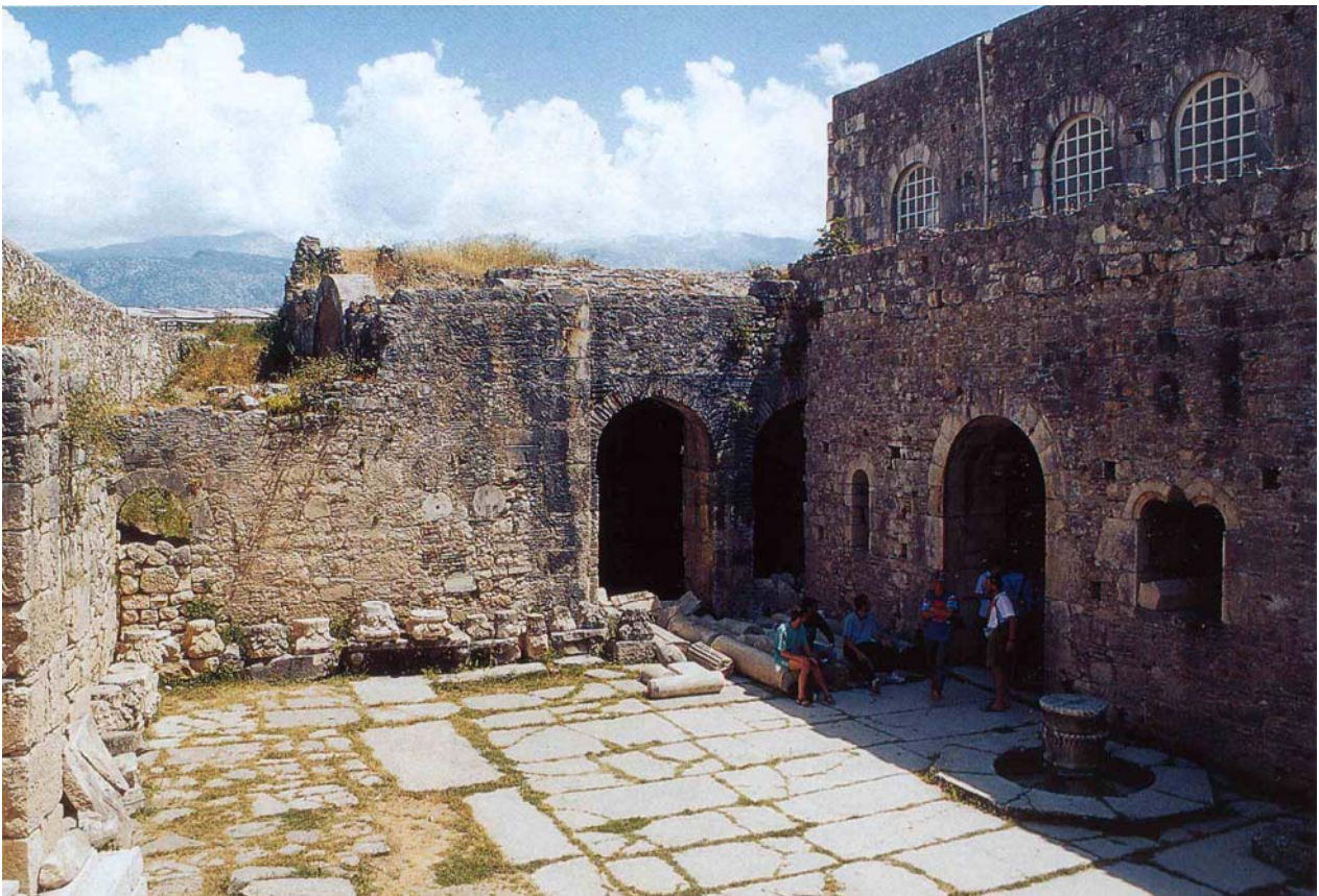
Cortile anteriore e facciata della chiesa di san Nicola a Mira
