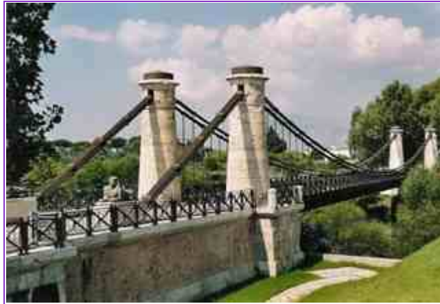
il ponte in ferro sul Garigliano "Real Ferdinando"
