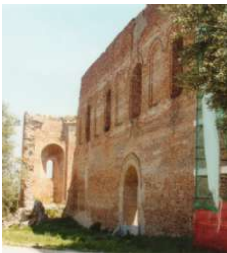
Parte dei resti dell'ex- Monastero ortodosso del X/XI° sec.: " La Roccelletta " a Rocella Jonica (R.C.) - [Foto 2003]
