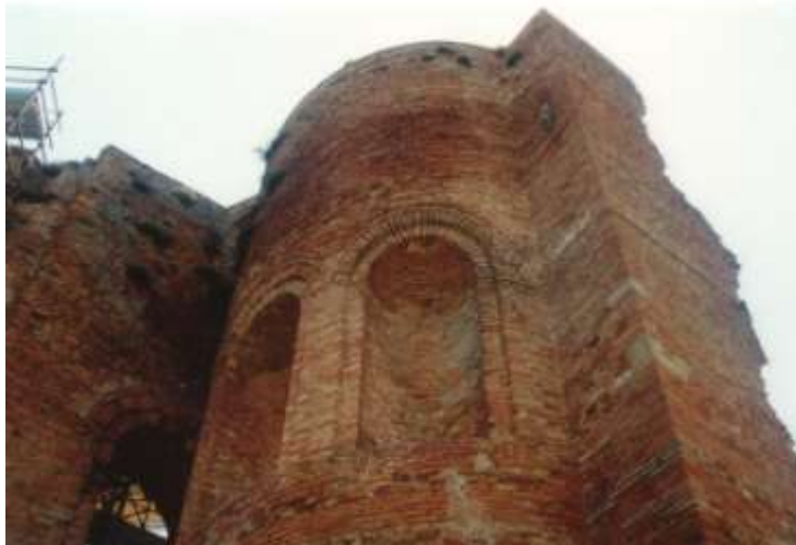
Parte dei resti dell'ex- Monastero ortodosso del X/XI° sec.: " La Roccelletta " a Rocella Jonica (R.C.) - [Foto 2003]
