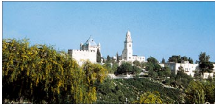
Chiesa-Basilica della Dormizione della Vergine sul Monte Sion, a Gerusalemme.
